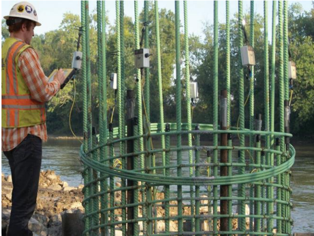
(杭頭のデータロガー)
